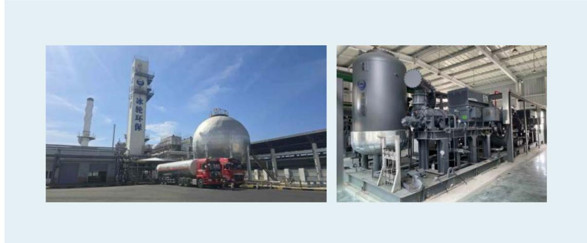
采用“吸附净化与双塔低温精馏组合法”成套技术，捕集万华化学MDI一体化项目煤制合成气低温甲醇洗脱碳装置排放的尾气中的CO<sub>2</sub>，增压提纯液化成高纯度液体CO<sub>2</sub>。实现CO<sub>2</sub>废气的综合利用，减少碳排放，变废为宝。
